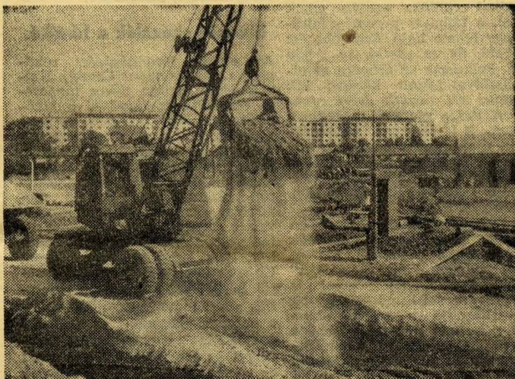
A héten megkezdték a volt Valéria-telepen a nagyszabású lakásépítkezés első szakaszának alapozását.
