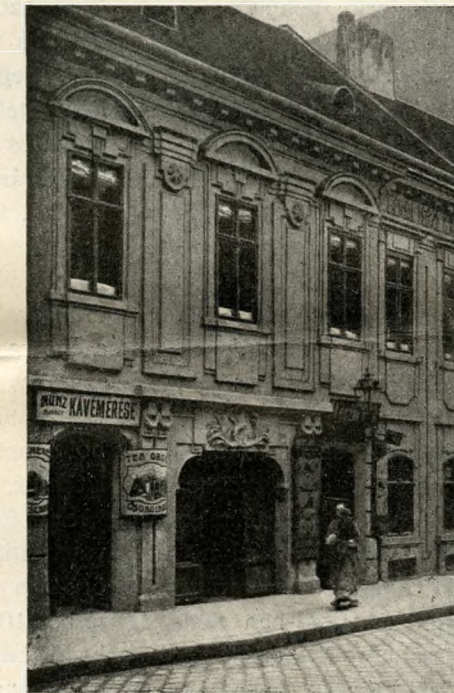
A Síp-utca 8. számú ház homlokzata.
