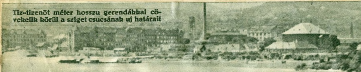
(150 méterrel meghosszabbítják a Margitsziget északi csucsát. Ide építik az óbudai híd középső főtartó pillérét. A Margitsziget meghosszabbításával megkezdődött az Árpádhíd építése, amelyet 1946-ban fejeznek be)
