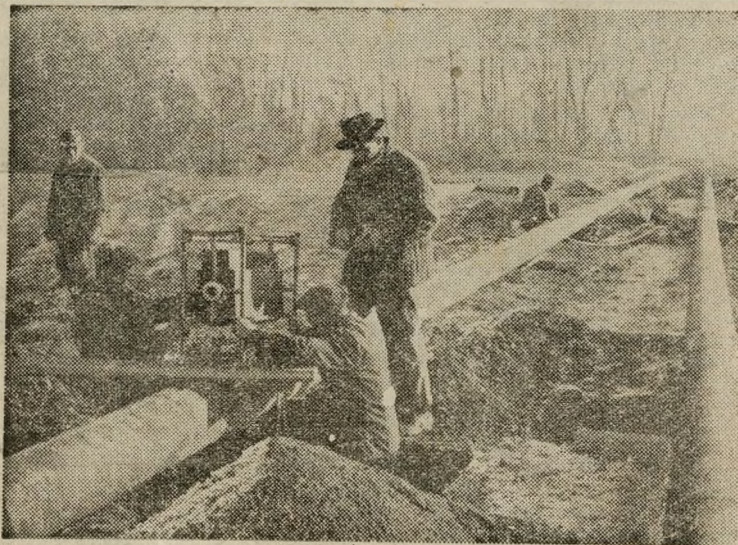
Röntgenzik a Duna alá kerülő gázcsövet. A tízméteres darabokból összehegesztett fél kilométer hosszú vezeték minden összeillesztését átvilágítják.
