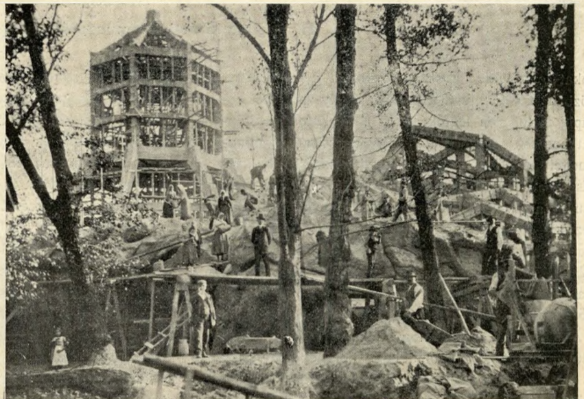
Az állatkerti nagy hegy belső váza készen; alul kezdik a hegyoldalt építeni.
