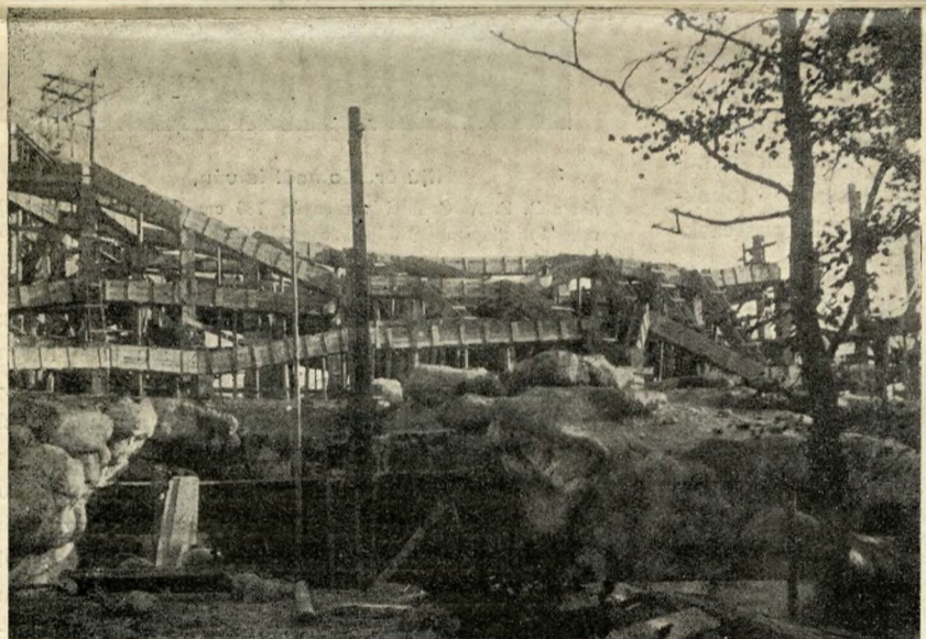
Az egyik hegyoldal belső vázáinak gerendái, deszkái; alul barlangbejárat készül.
