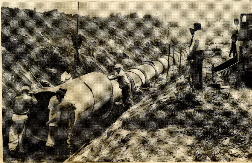
A II. szigetmisklói víztermelő telep első ütemének megvalósítása során megkezdték a 7 kis csáposkút építését és a hozzájuk tartozó nyomócsövek fektetését. Képünkön: daru emeli be az egyes csőszakaszokat, amiket a munkások azonnal helyükre illesztnek
