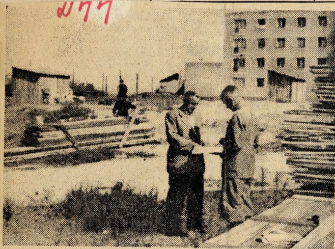
277 Árkosi Antal építészvezető a tervrajzok alapján Zima Miklós főművezetővel megbeszéli a felvonulás következő szakaszát.
