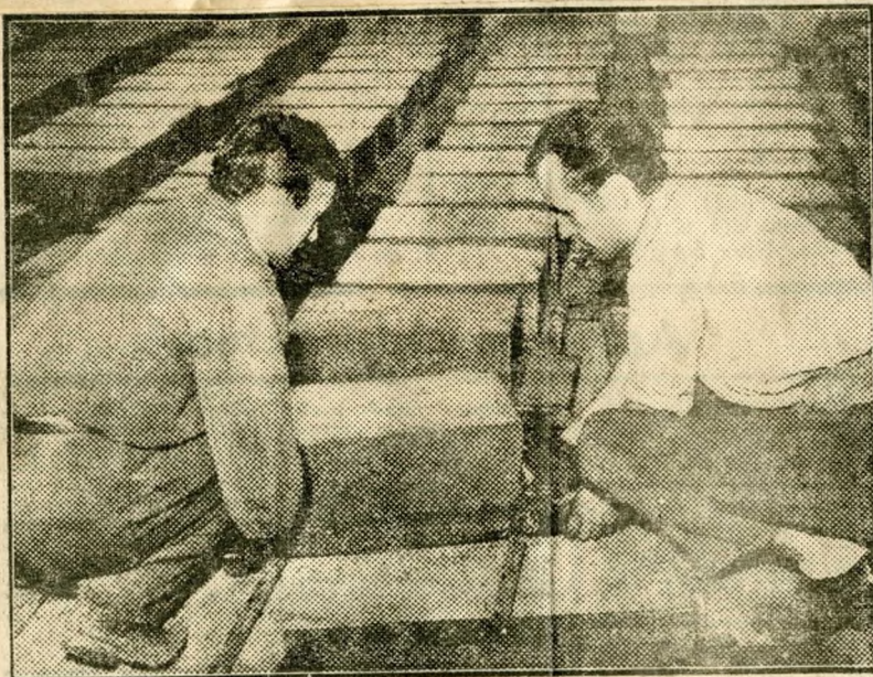
A Földalatti Vasútépítő 1-es telepén gyártják a betonidomköveket, amelyekkel az alagutak egyrészét bélelik majd. Balogh Pál és Juhász Gyula segéd munkások elhelyezik a betonidomköveket.
