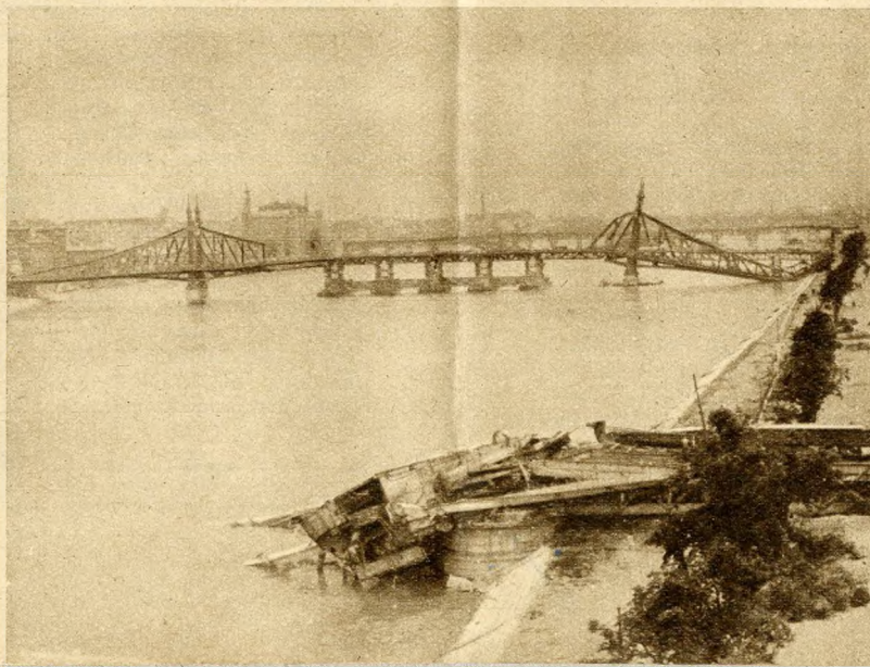
A Szabadság-híd maradványain átvezető ideiglenes, öt uszályon álló hajóhid. Előterben az Erzsébet-híd ledőlő balai kapujának romjai
