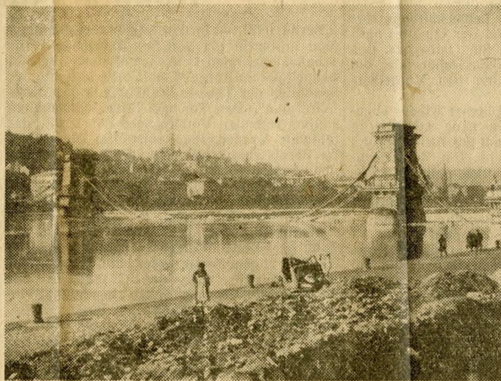
Blick vom Donau-Korso auf die bei den Kämpfen zerstörte Kettenbrücke, die die älteste und schönste in Budapest ist. (AP)
