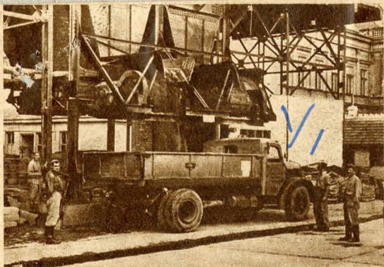
A csilleplató tartányából futószalag szórja a földet a szállító teherautóra
