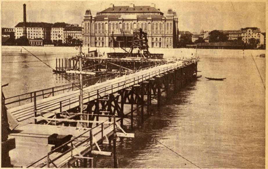
Munkahíd a mederpillér építéséhez.
