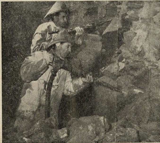
Légkalapáccsal dolgoznak az alagútfúrásnál
