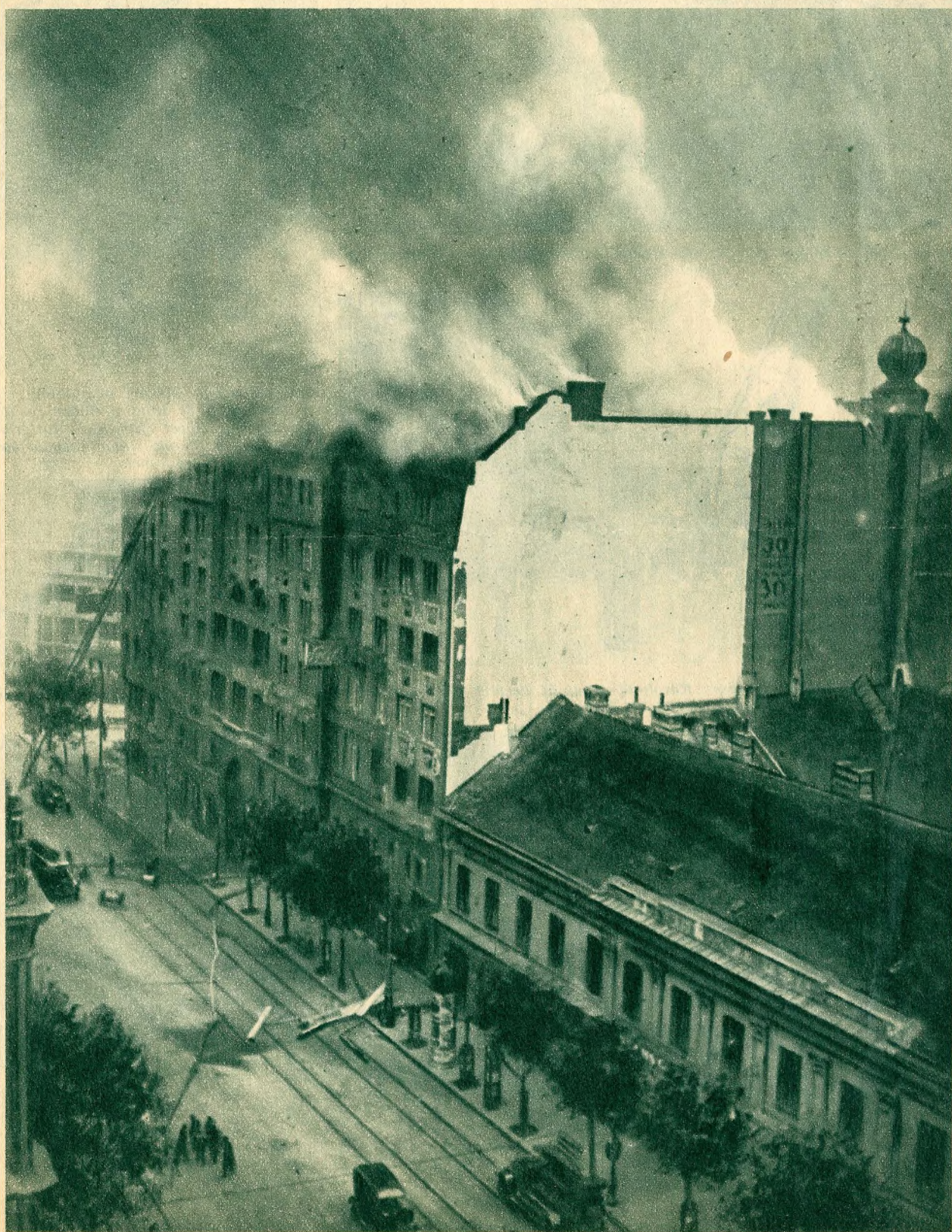
Szerdán délelőtt hatalmas tűz pusztított Budapesten: kigyulladt a Károly-körút 3. sz. alatti hatemeletes bérpalota tetőzete. A tűzvész óráról-óra erősödött, annak dacára, hogy a tűzoltók óriási erőfeszítéssel igyekeztek azt lokalizálni. A déli órákban az égő palota félelmetes látványt nyújtott.
