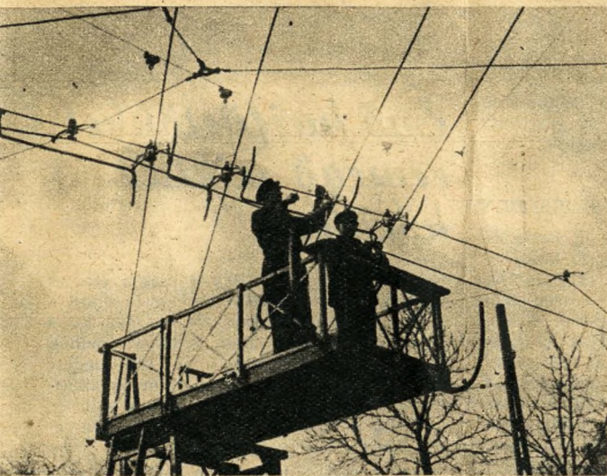
Heggyeszőgű villamos-trolibusz keresztezés szerelése
