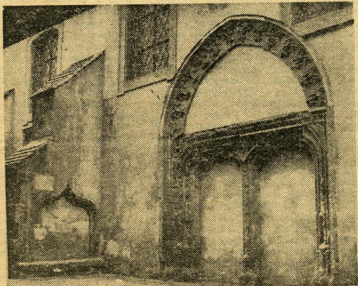
A Belvárosi Plébániatemplom Mátyás-korabeli bejárata és a kolduspád körül a felszívódó talajnedvesség okozta foltok éktelenkednek
