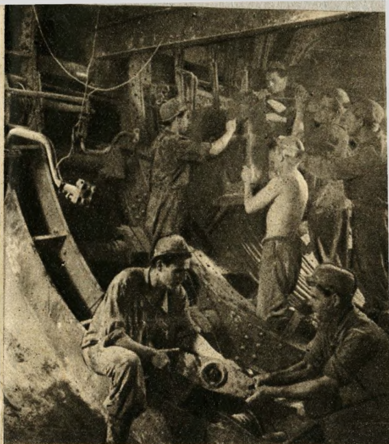
A fúrópajzs szerelése
