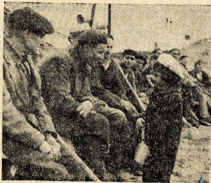
A képen: egy rákospalotai kislány barátkozik a csatorna építőivel
