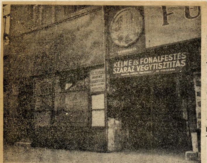
Bajcsy Zsilinszky út 14. Bádoglemezzel burkolt portálon elhanyagolt üvegtábla jelzi a Villamosipari Központi Kutató Laboratórium helyiségét.
