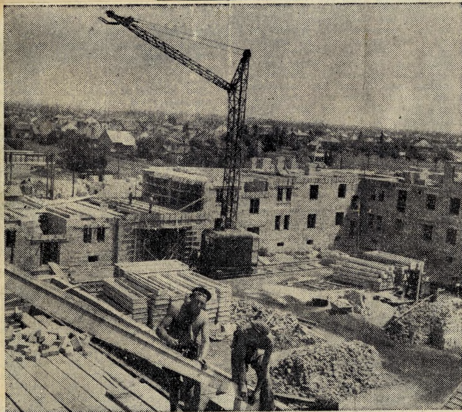
A sztahanovista Sziráki állványozóbrigád előregyártott tetőszerkezetet szerel. A brigád háromhavi átlaga 248 százalékos.
