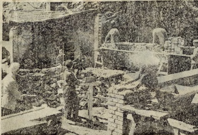
Előtérben az építkezés. Háttul a korszerűtlen, régi műhely látható.
