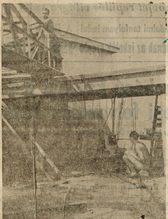
Az érzékeny berendezés megmutatja, milyen lesz 100 év múlva a hídszerkezet teherbírása
