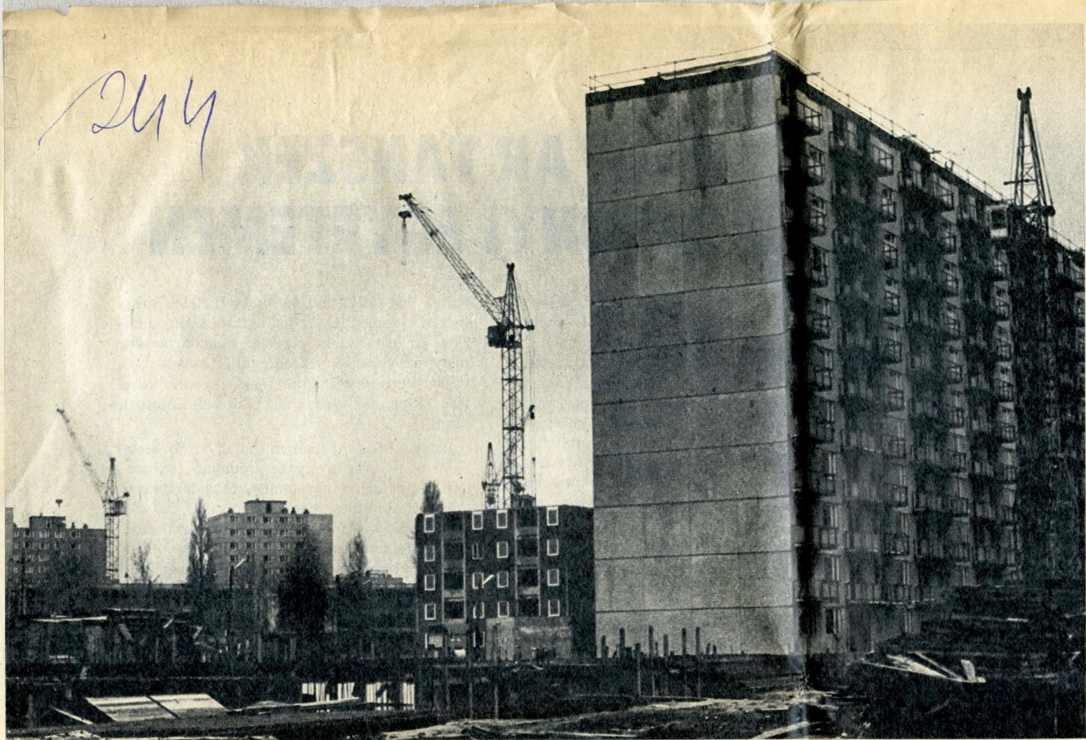
Részlet az épülő Újpalotáról
