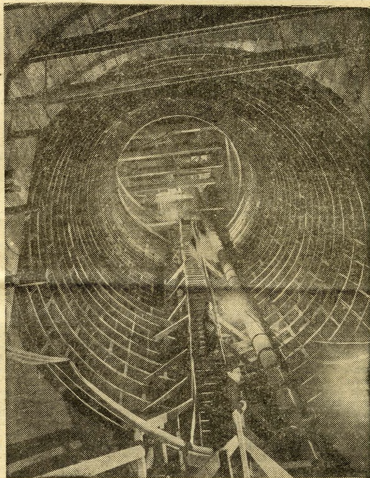
Ilyenek a pesti utcák alatt húzódó ferde alagutak, amelyekbe a mozgólépcsőket építik majd.
