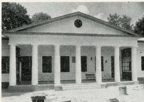
2. Óra-villa a helyreállítás után. (Terv : Lipták Irén)
