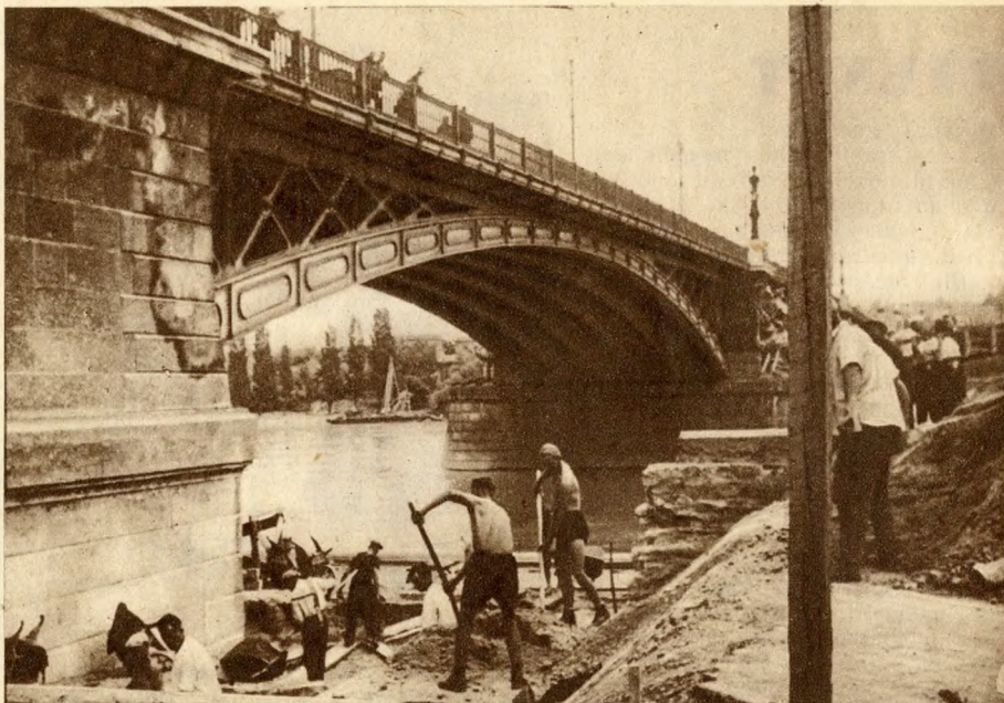
Megkezdődtek a Margithid kiszélesítési munkálatai. Felső kép: alapozási munka a hid déli oldalán. Alsó kép: bontás a hídfőnél.
