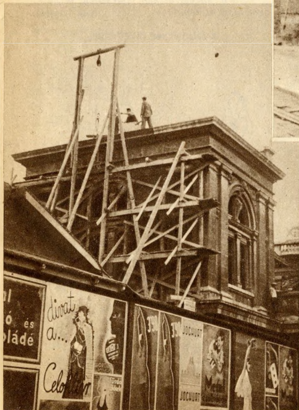
A budai oldal haláraitolt hídvám-épülete.
