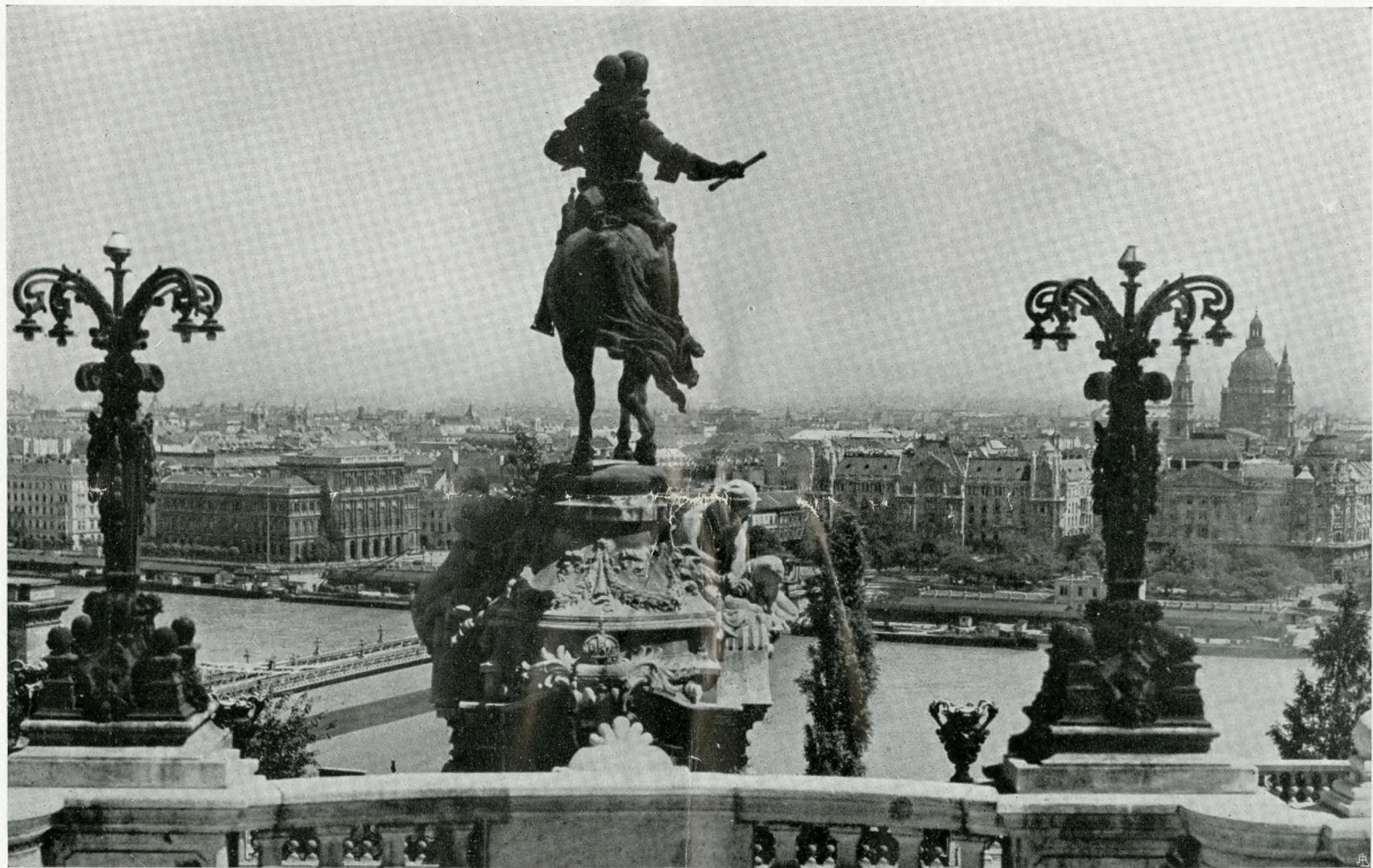
IL MONUMENTO A EUGENIO DI SAVOIA E LA MODERNA PEST, DAL BALCONE DEL PALAZZO REALE
