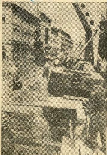
A csőhálózat bővítése acélesüvek felhasználásával
