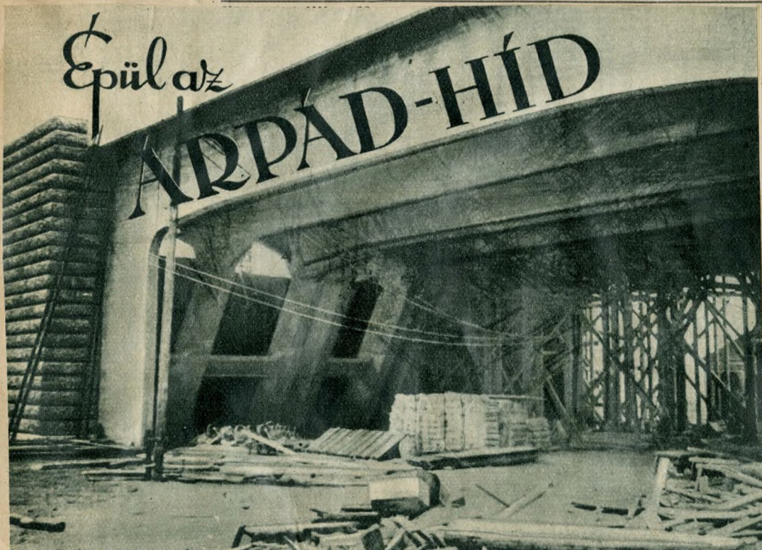
A híd első betoníve az óbudai parton
