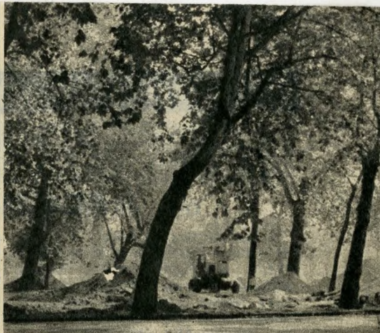
Törlik a beton- és kőmaradványokat.
