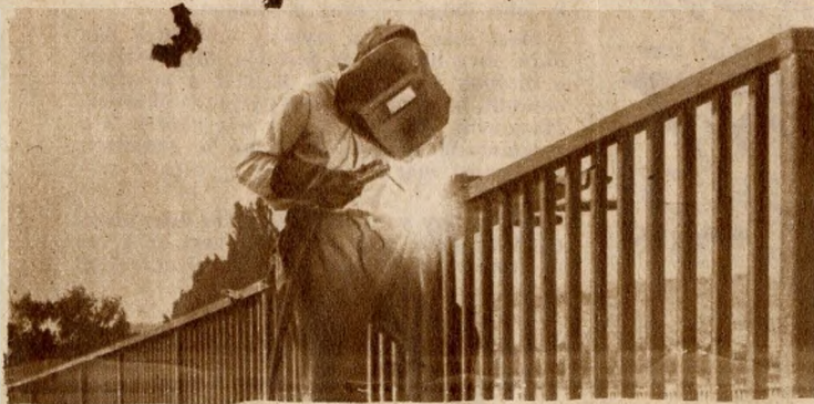
Tűző napfényben szikrázik a hegesztőpisztoly a margitszigeti hídlejáró karfáján
