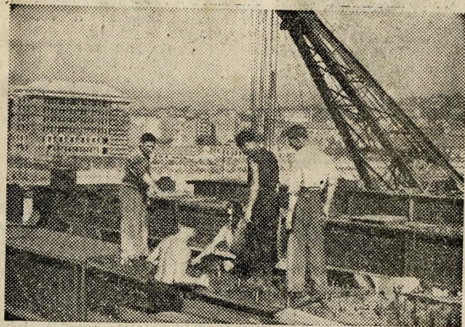
Az épülő Petőfi-hídon is lelkes munka folyik a koreai műszakban. Nagy László elvtárs és szerelőbrigádja részese volt annak a munkának, amelynek során egy nap alatt három hatalmas alsó-övtartót szereltek be.
