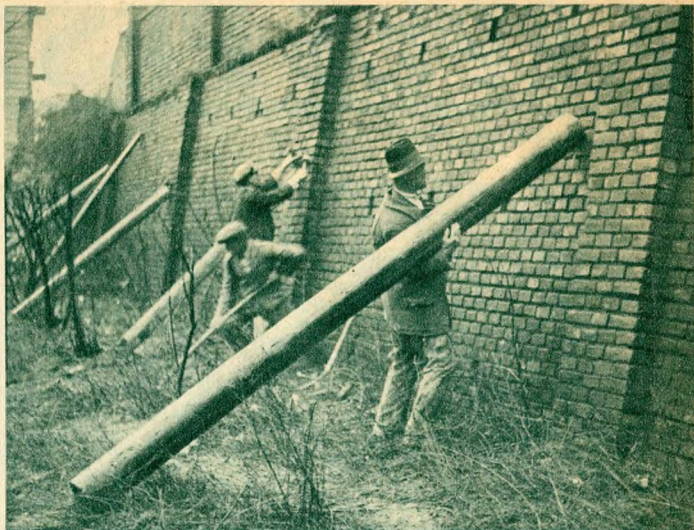
Alátámasztják a Lógody-utca kőkerítéseit a kedd éjszakai leomlás következtében. Alsó kép: munkások dolgoznak a Várhegy-oldalban a talajcsuszamlást megállító támfal építésén.
