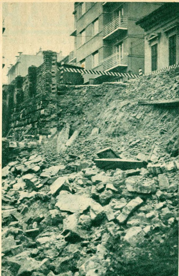
A Lógody-utca egyik kőkerítése tíz méter hosszúságban kedden éjjel a várhegyi talajcsuszamlás következtében leomlott.
