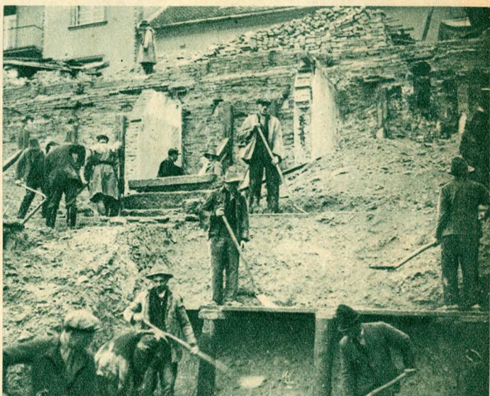
Alátámasztják a Lógody-utca kőkerítéseit a kedd éjszakai leomlás következtében. Alsó kép: munkások dolgoznak a Várhegy-oldalban a talajcsuszamlást megállító támfal építésén.
