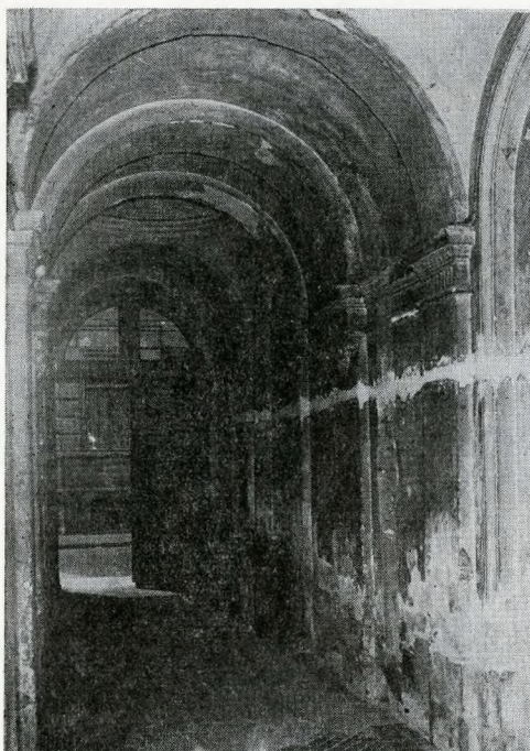
3. Az épület bejárata
