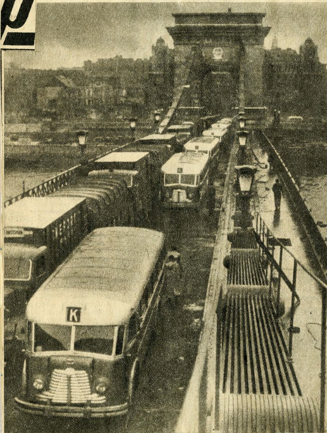
Élettel, mozgással telt meg vasárnap délelőtt az újjáépült Lánchíd. Autobuszok, tehergépkocsik kanyarodtak az újonnan készült feljárón át a híd úttestére. Gerő Ernő államminiszter jelenlétében terhelési próbát tartottak a hidépítő szakértők. Tizenegy autobusz és tízennégy hatalmas, pótkocsis, kockakövekkel megrakott teherautó 637 tonnányi súllyal gördült az újjáépült hídra. A Lánchíd már 1900 tonna terhelést bír el, 12 százalékkal nagyobb a teherbírása mint a régié volt
