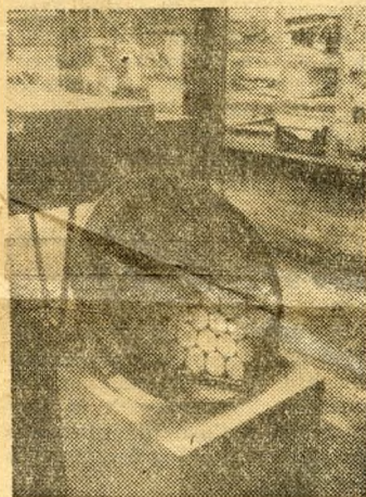
Az új Erzsébet-híd tartókábelének keresztmetszete
