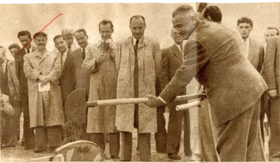
AZ ELSŐ KAPAVÁGÁS. 1948 júniusában Hegyi Gyula, az OTSB elnöke kapavágása után megkezdték a Népstadion építkezését
