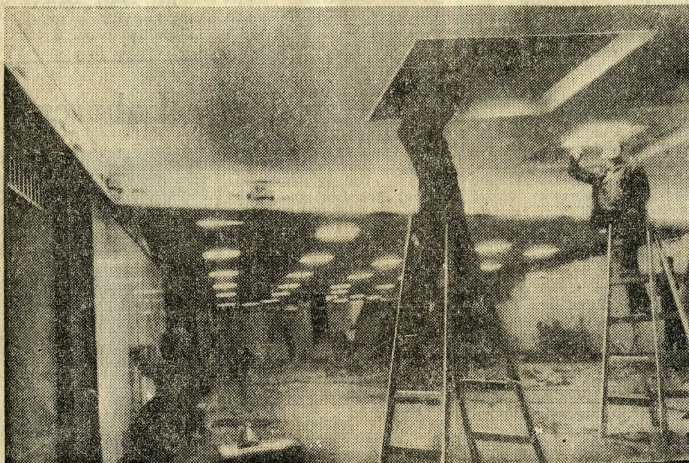
Szerelik a mennyezeti világító berendezést
