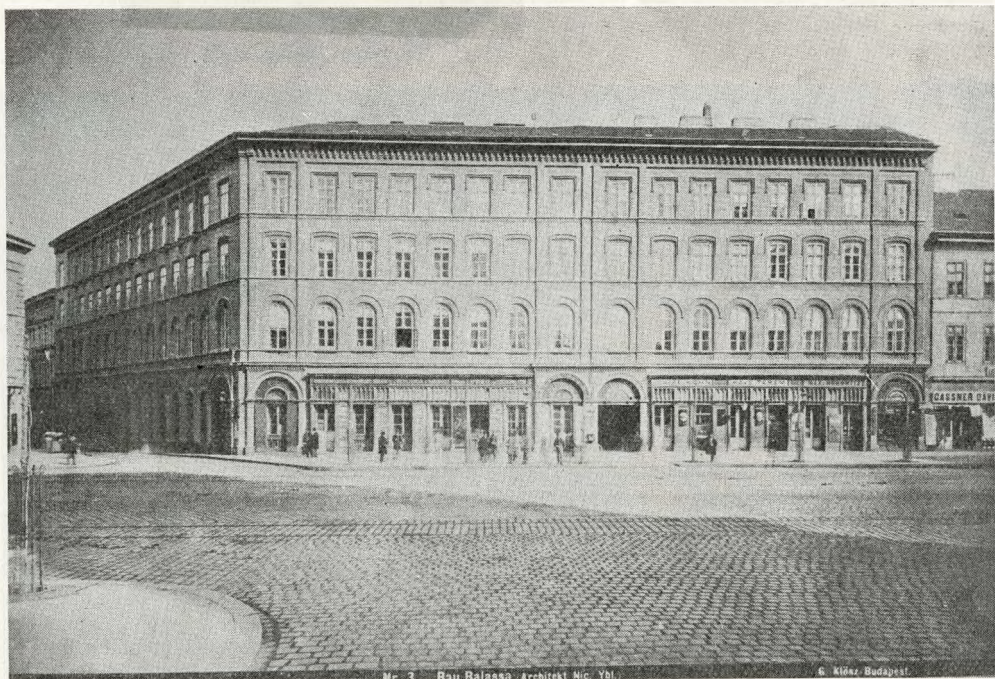
10. Bajcsy-Zsilinszky út 17., homlokzata a századforduló táján
