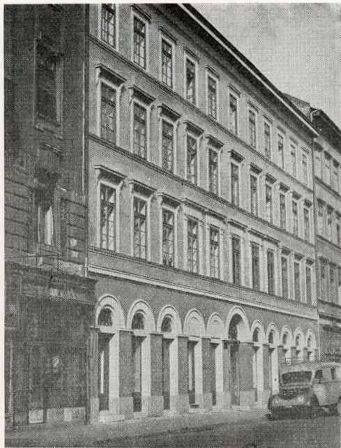
12. Majakovszkij u. 36. sz. Műemlékjellegű épület helyreállítás után
