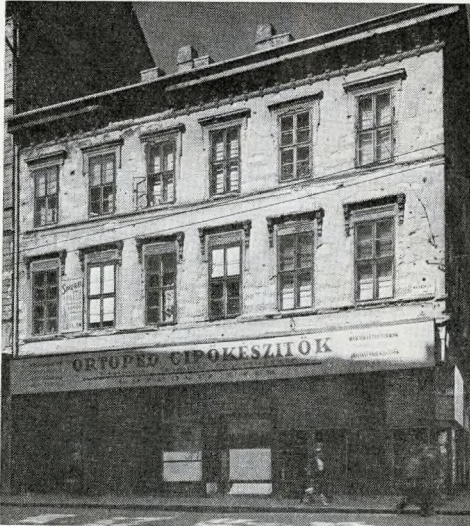
6. Liszt Ferenc tér 7. Oldalhomlokzat helyreállítás előtt (1957)
