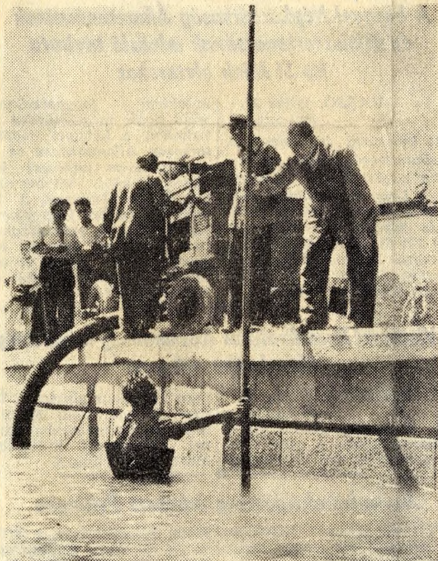
A Lánchíd pesti hídfője alatt a mélyenfekvő kocsutát másfélméteres, több ezer köbméternyi visszamaradt víz borította. A híd lábánál motoroszivattyú működött, amely a vizet visszazállította a Dunába.
