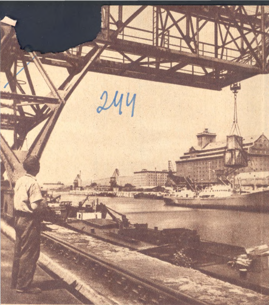
Működésben a híd-daru
