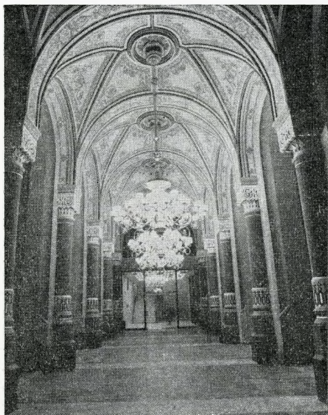
2. A rekonstruált keresztboltozatos folyosószakasz
