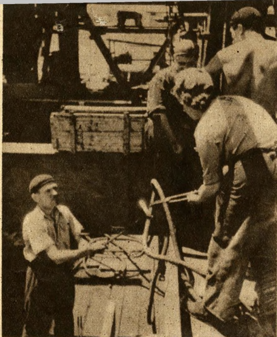
Szabó Ilonka, aki Tárkevéről jött fel Budapestre, az egyik szegecselőbrigád tagja a Boráros-téri híd építésénél
