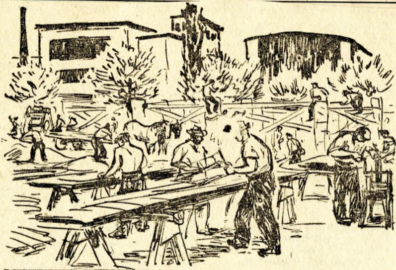
Készülnek a zsaluk a vasbetonhoz, dolgoznak az ácsok. Háttérben a Ganz Vagongyár tanműhelyei.
