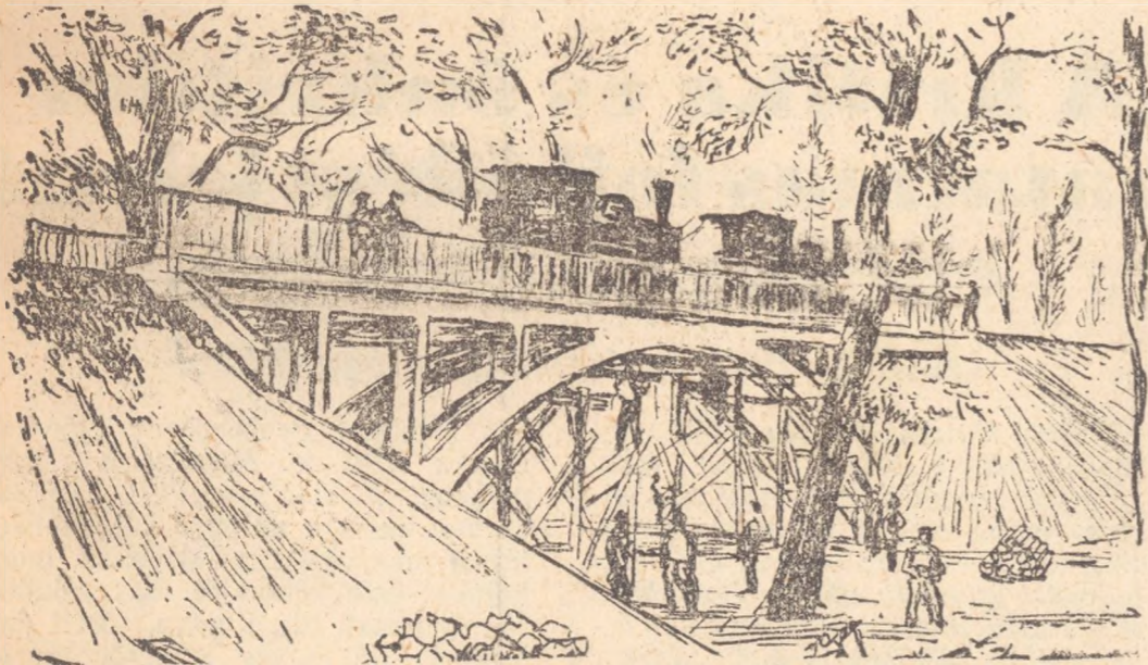
Mozdonyok teherpróba közben az új hídon.
