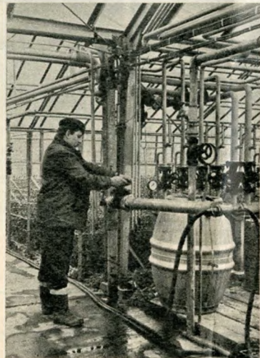
Felvételünkön látható berendezés a tápoldatok kijuttatását szolgálja (Rozmaring Tsz)
