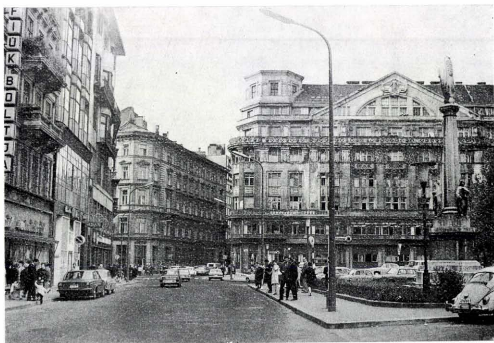
Szervita tér – Martinelli tér. A képek a Petőfi Sándor utca torkolatából készültek észak felé, a Bécsi utca irányában. A tér két sérült házát lebontották, jelenleg park és játszótér van helyükön. A Fehérhajó u. 2. sz. eklektikus bérház saroktoronyáról a helyreállítás során lehagyták a kupolát
