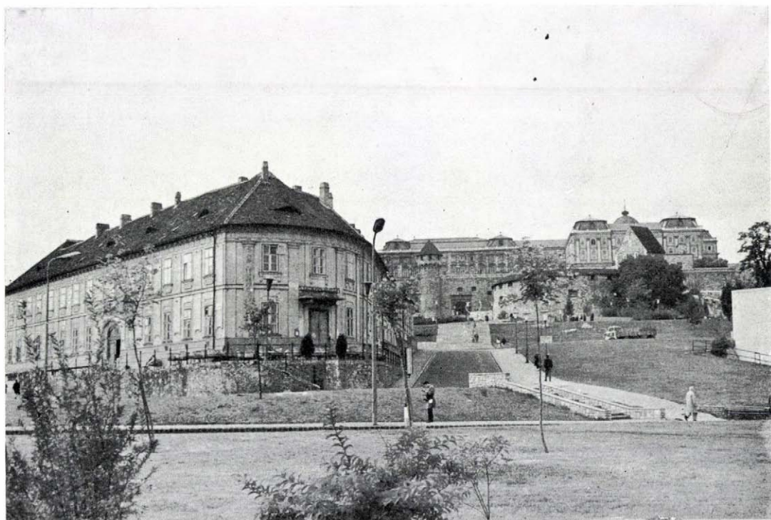
A Várpalota a Szarvas tér felől. A baloldalt álló Szarvas ház kivételével a többi épületet lebontották 1946-47-ben. 1966-67-ben a Váralja utcai Ybl – Hauszmann-féle falat és kutat is lebontották, új feljáratot építettek a Ferdinánd kapuhoz, s az újjáépített védőmű rendszerhez
