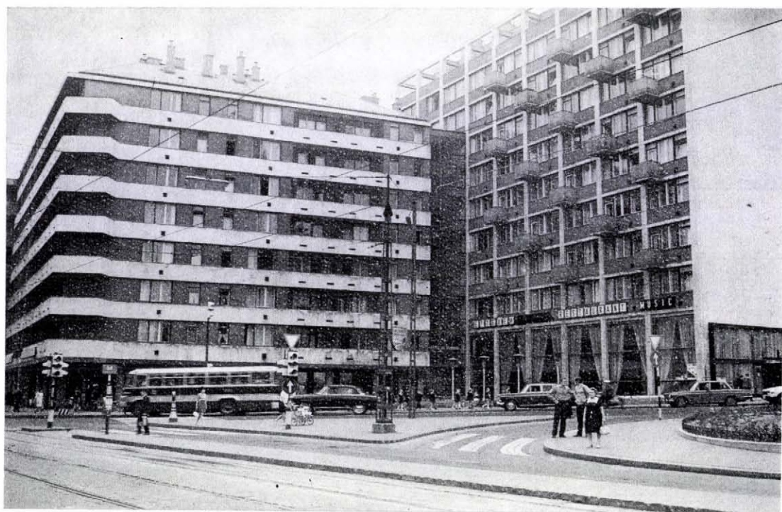
A Krisztina tér déli oldala. Az előző képen látható új épület északi, meglehetősen nyugtalan és a teret egy nyolcemeletnyi kopár fallal lezáró homlokzata
