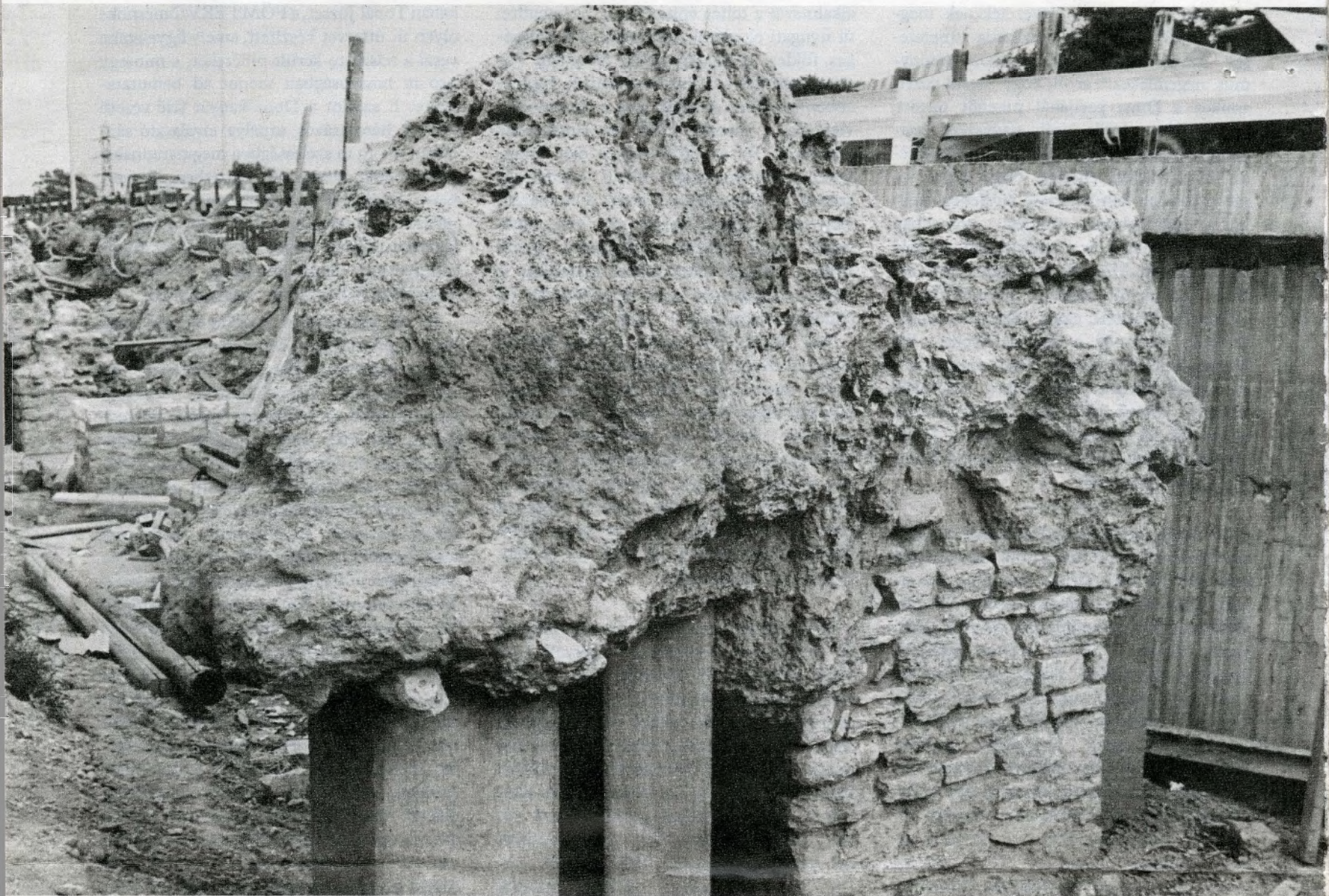
Pillér a rárakódott konglomerátummal
