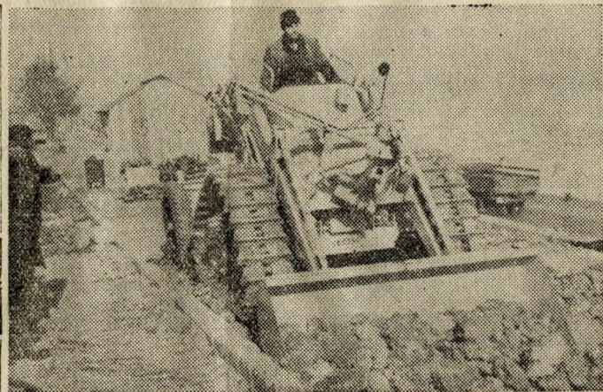
Munkában a különleges földvájó gép
