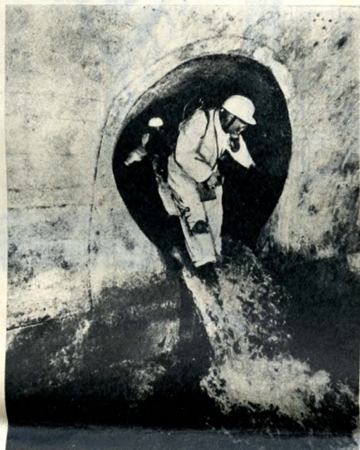
Gázálcross szakemberek ellenőrzik a csatornát
